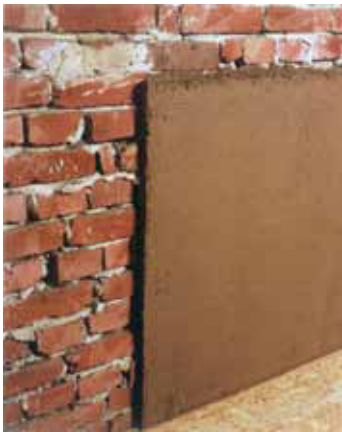
Ausgleichsschicht mit conluto Lehm-Unterputz
